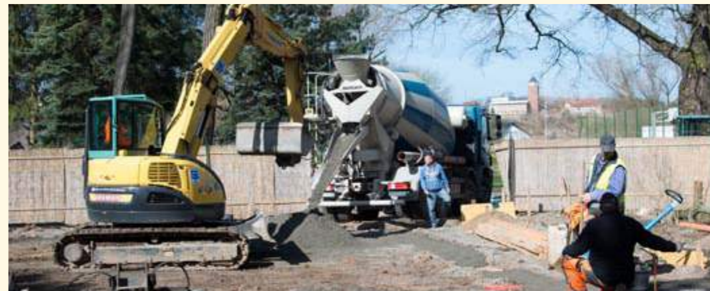
Im Frühjahr 2017 beginnen die Fundamentarbeiten für das neue Tropicana. Bis zum Sommer soll bereits der Baukörper stehen.
