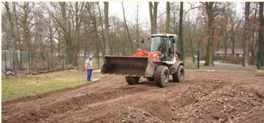
Das umzäunte Grundstück der Landestalsperrenverwaltung grenzt direkt an den Tierpark, der hinten auf dem Foto zu sehen ist. An besucherstarken Tagen und bei Veranstaltungen finden hier künftig mindestens 30 Autos Platz.
