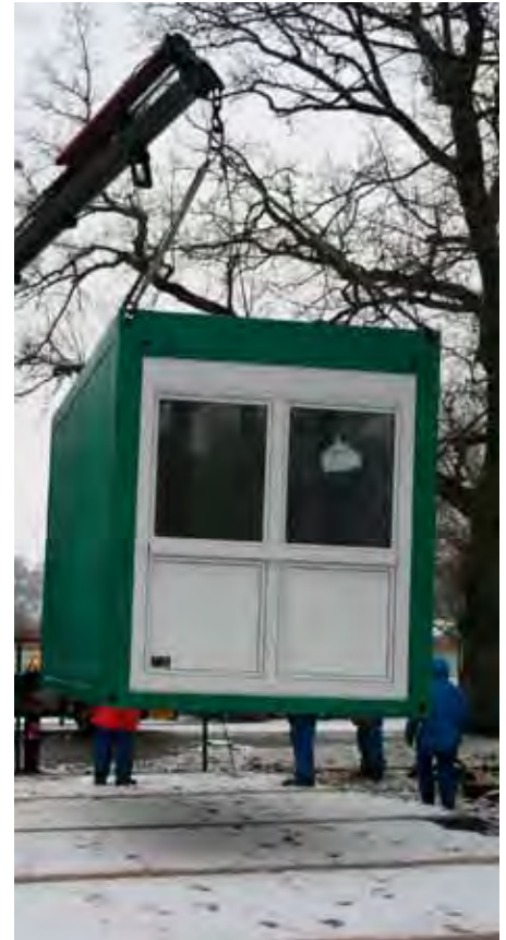
Das erste Teil für Alien World schwebt am Kranhaken. Insgesamt wurden am 11. Februar zehn Container an Ort und Stelle gebracht.
